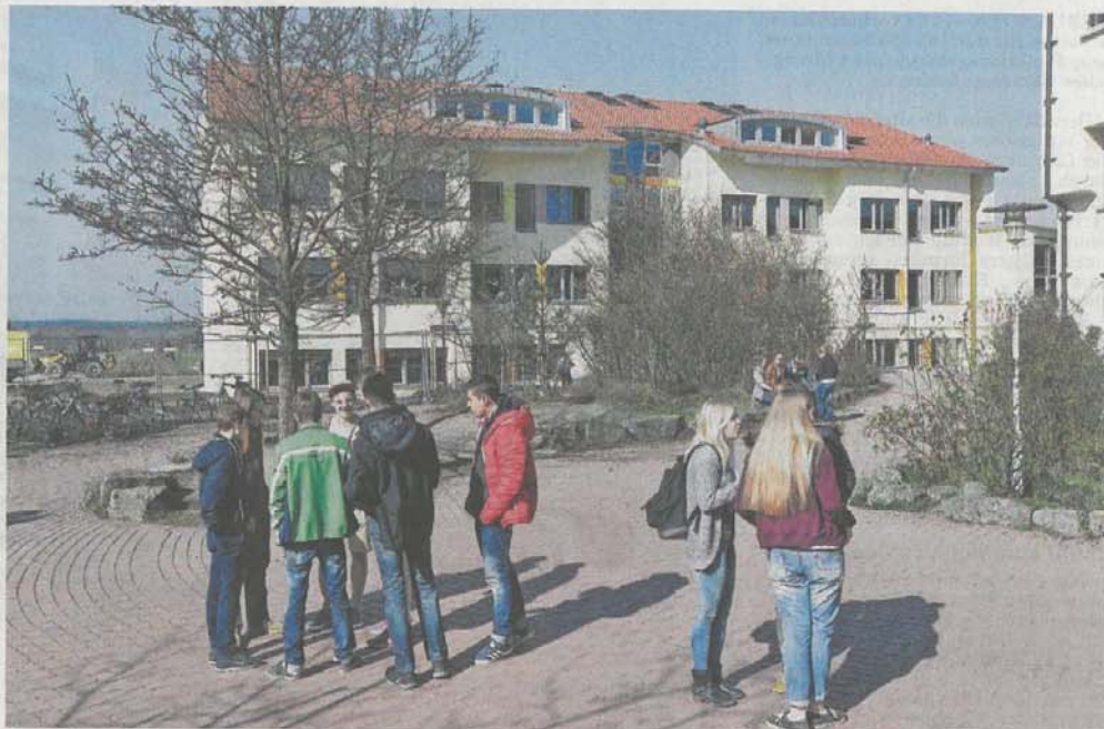
Bereits Ende Januar sind die Jugendlichen in das neue Gebäude der Freien Waldorfschule eingezogen, morgen wird das großzügig gebaute Haus feierlich eingeweiht. Fotos: Harald Sippel
